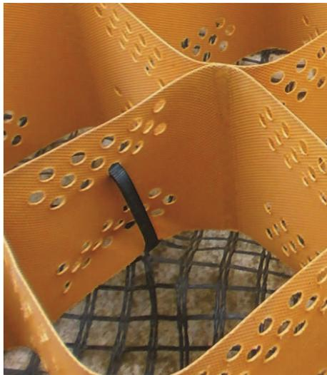
Figure 1. Colliers de serrage du géoconteneur sur la géogrille.
