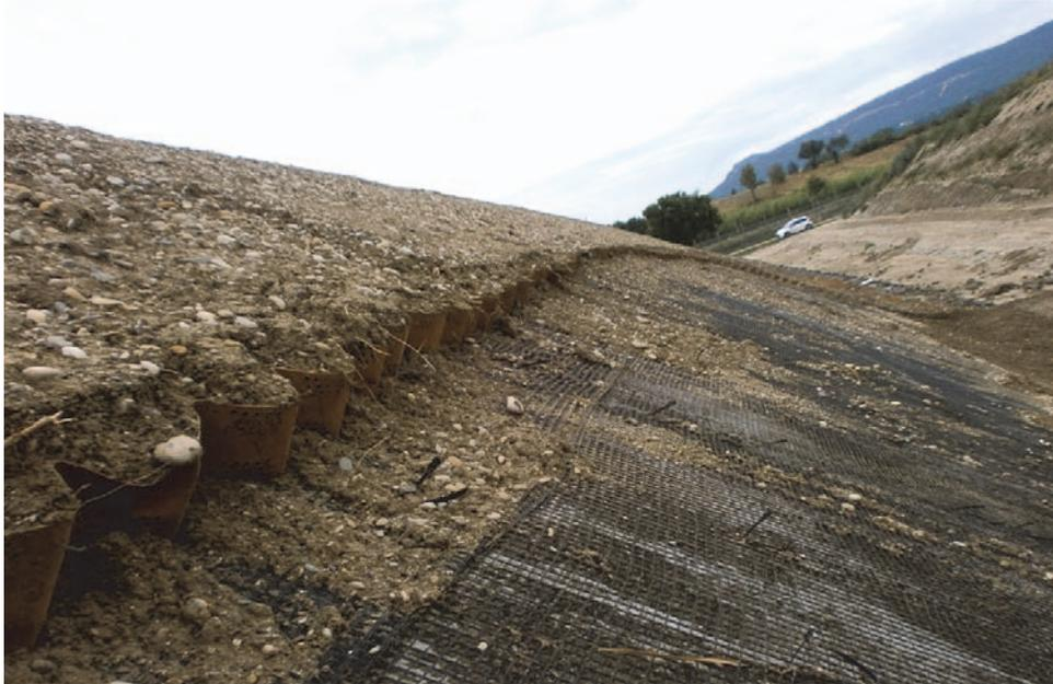
Figure 6. Détail de la rupture au niveau de la jonction entre les lés.
